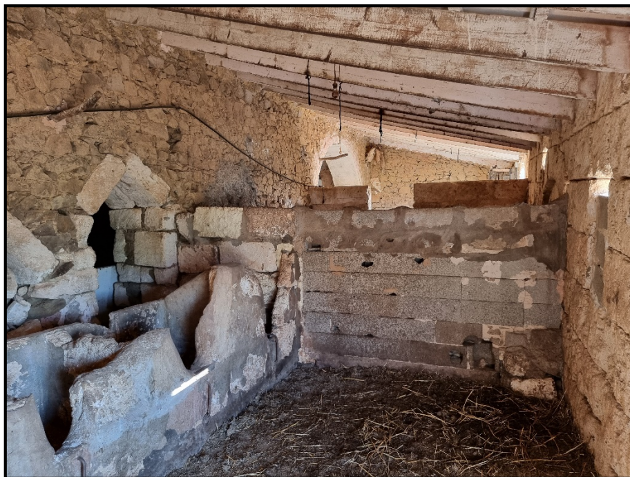
Foto 1.- Interior establos a reformar.
