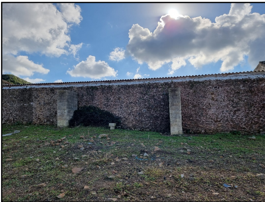
Foto 4.- Exterior establos a reformar.
