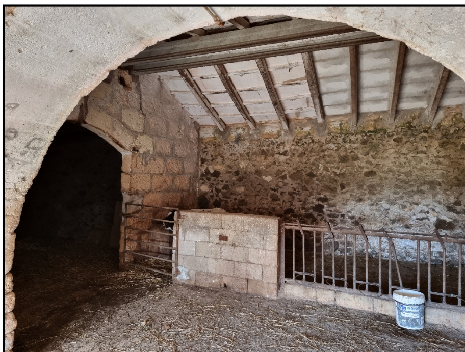
Foto 2.- Interior establos a reformar.
