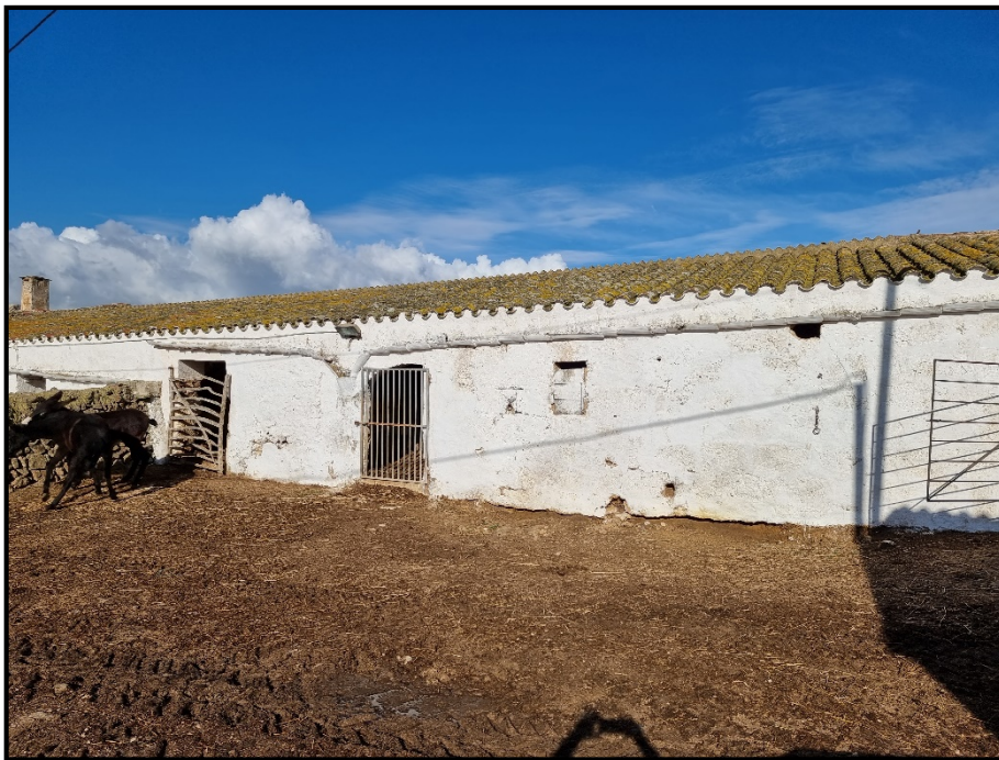
Foto 3.- Exterior establos a reformar.
